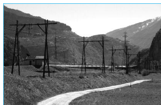
L'évitement ferroviaire de Pontamafrey
